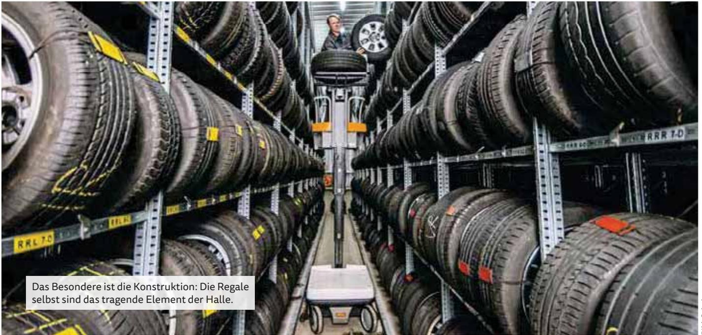
Das Besondere ist die Konstruktion: Die Regale selbst sind das tragende Element der Halle.
