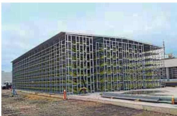
Das Besondere an den Cover-Hallen ist, dass sie von innen nach außen gebaut werden.
