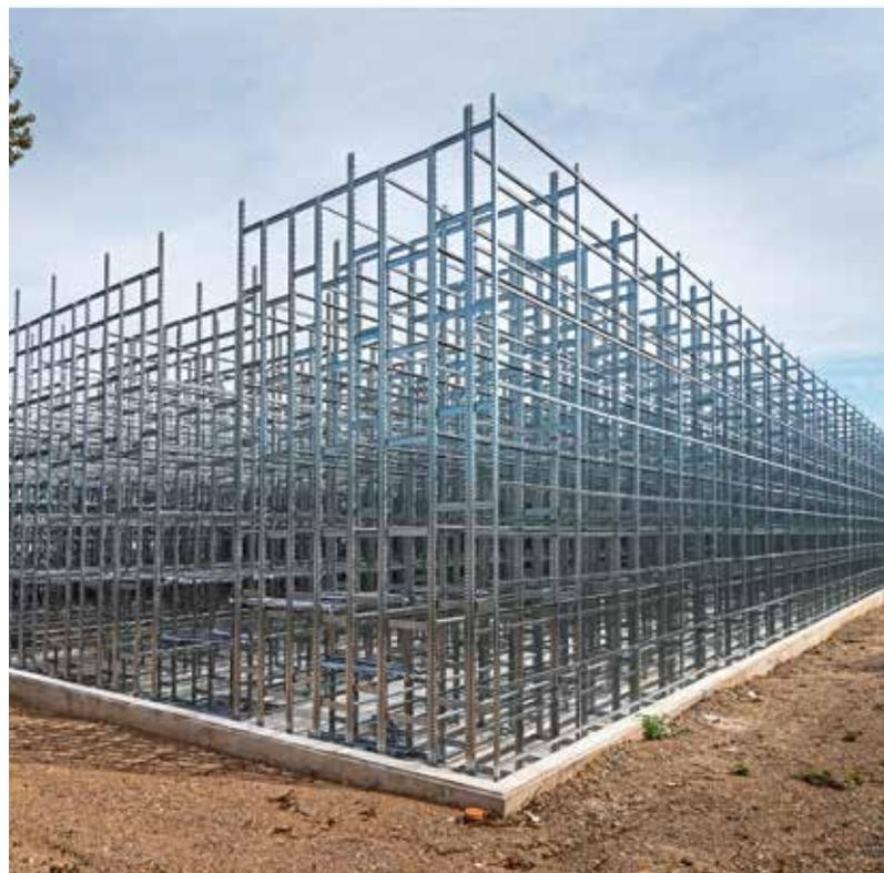
Die Scholz Cover-Hallen bestehen aus den patentierten Magazinregalen, die von einer hochwertigen Blechverkleidung ummantelt werden. Diese ist sowohl wetterbeständig als auch stabil.
