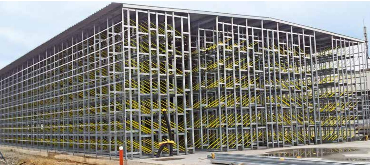
Das Besondere an den Cover-Hallen ist, dass sie gleichsam von innen nach außen gebaut werden.
