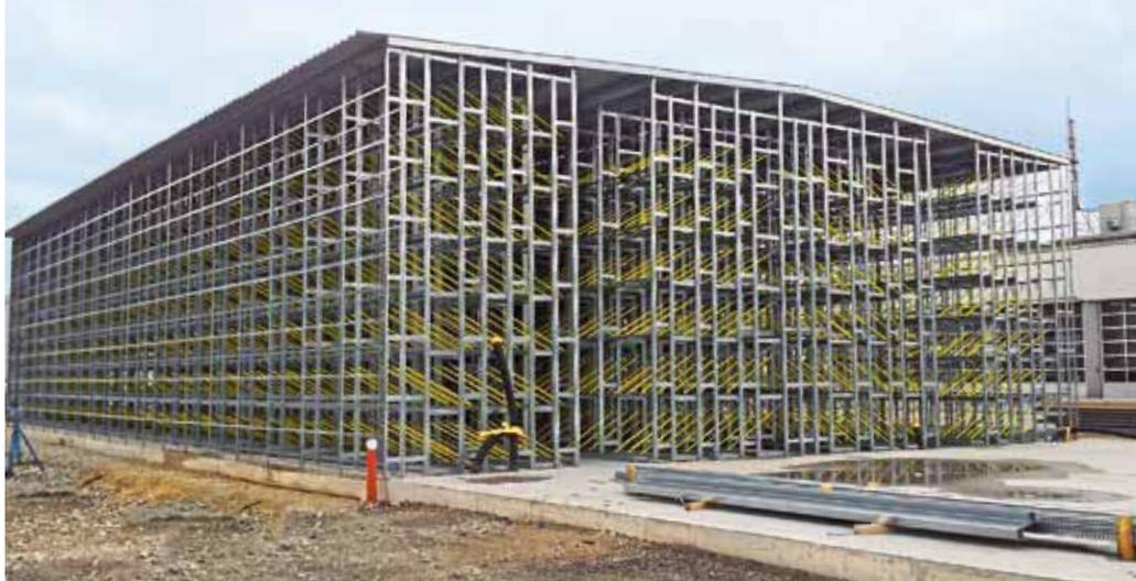
Das Besondere an den Cover-Hallen ist, dass sie von innen nach außen gebaut werden.
